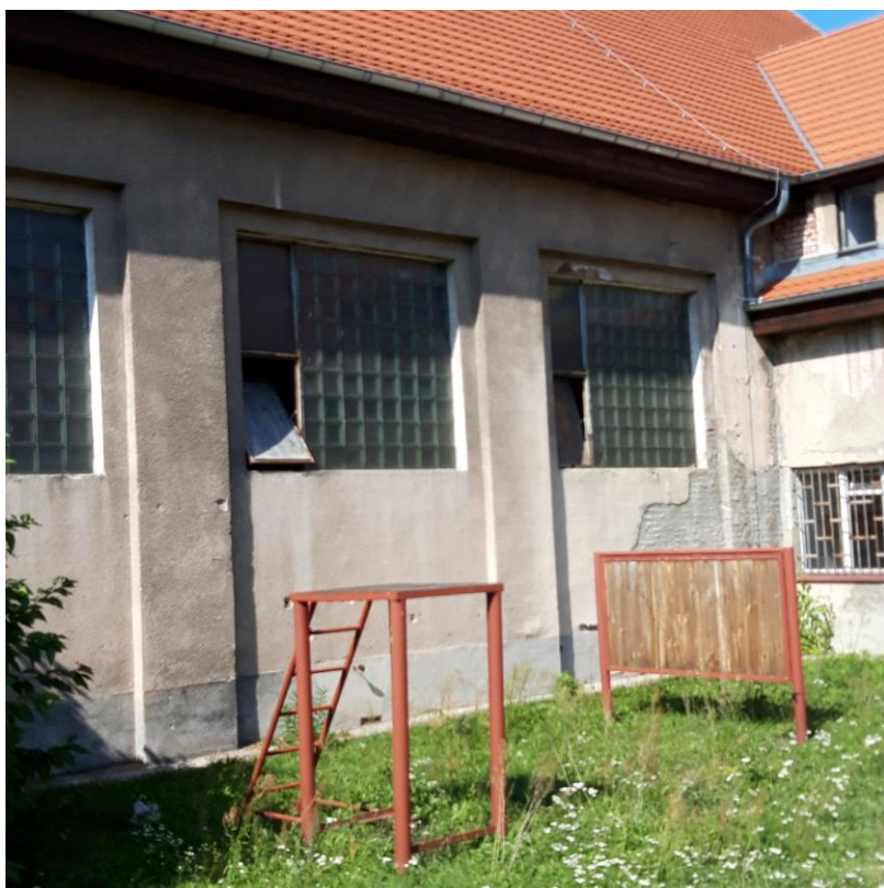
Fot. 1. Widok luksferów do usunięcia od strony placu.
