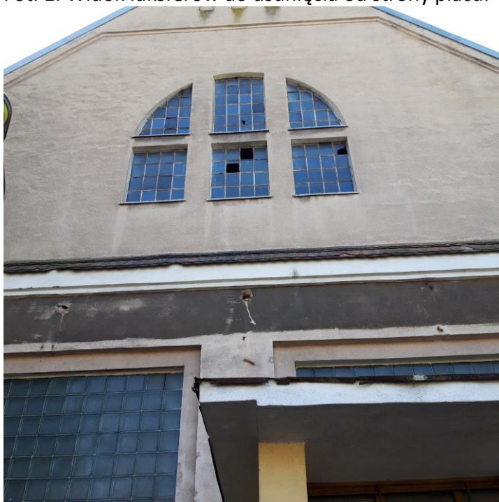
Fot. 2. Widok okien do renowacji z zewnętrznymi szprosami.
